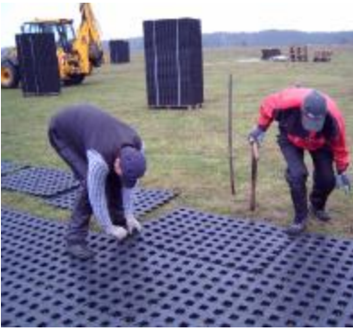
Matten am Boden in Position auslegen
