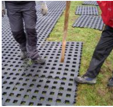
Matten durch Fußdruck auf den Haken miteinander verbinden
